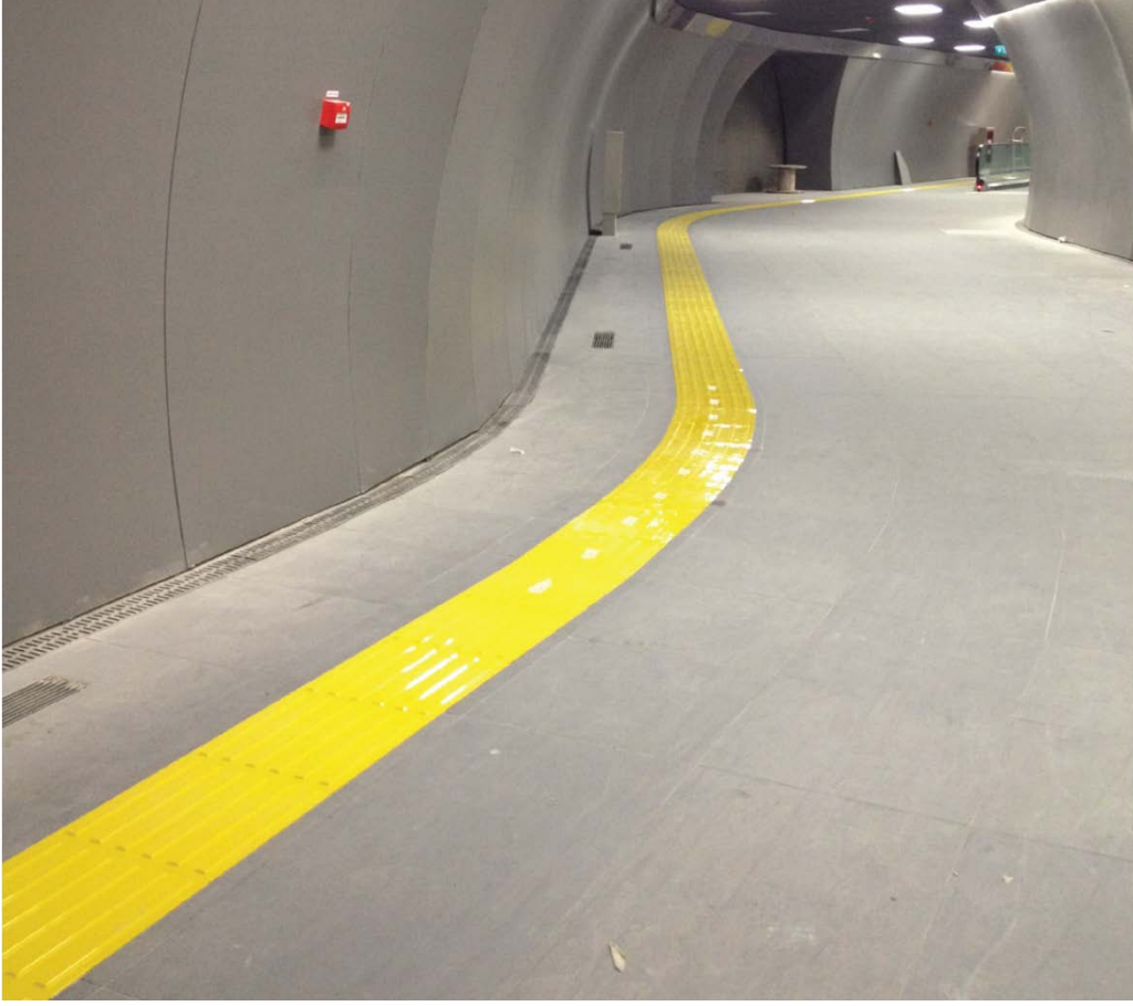
*Hissedilebilir yüzey (tabanlı) kaplama uygulama görünüşü*
