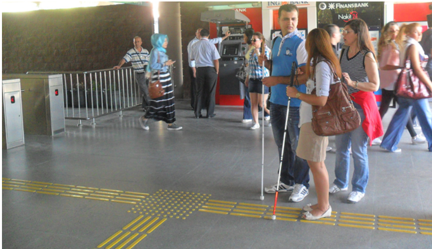
*Hissedilebilir yüzey (tabansız) uygulama görünüşü*
