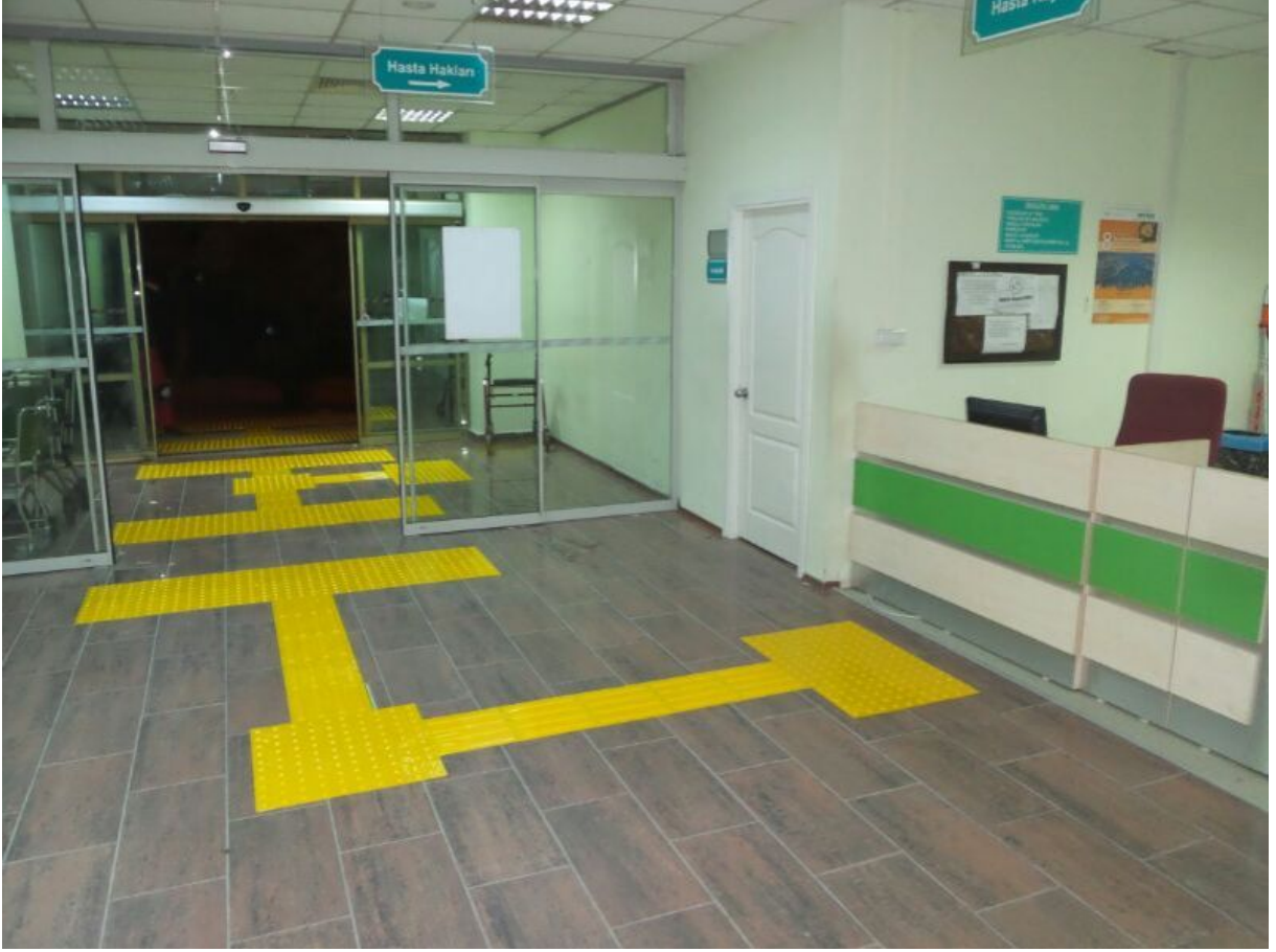
*Hissedilebilir yüzey (tabanlı) kaplama uygulama görünüşü* 1
