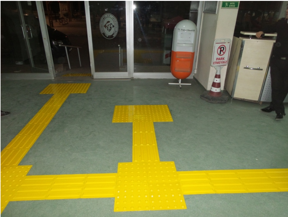
*Hissedilebilir yüzey (tabanlı) kaplama uygulama görünüşü*
